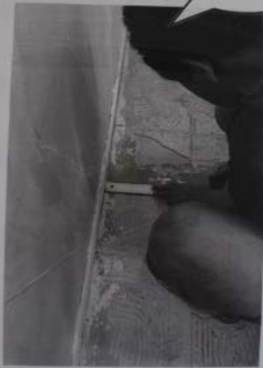
Implantation de la future cloison
