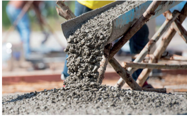
Le béton est frais, puis il se
